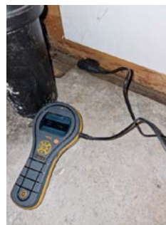
fuktmåling i bunnsvill ved bod, vegg mot dusjkabinett
