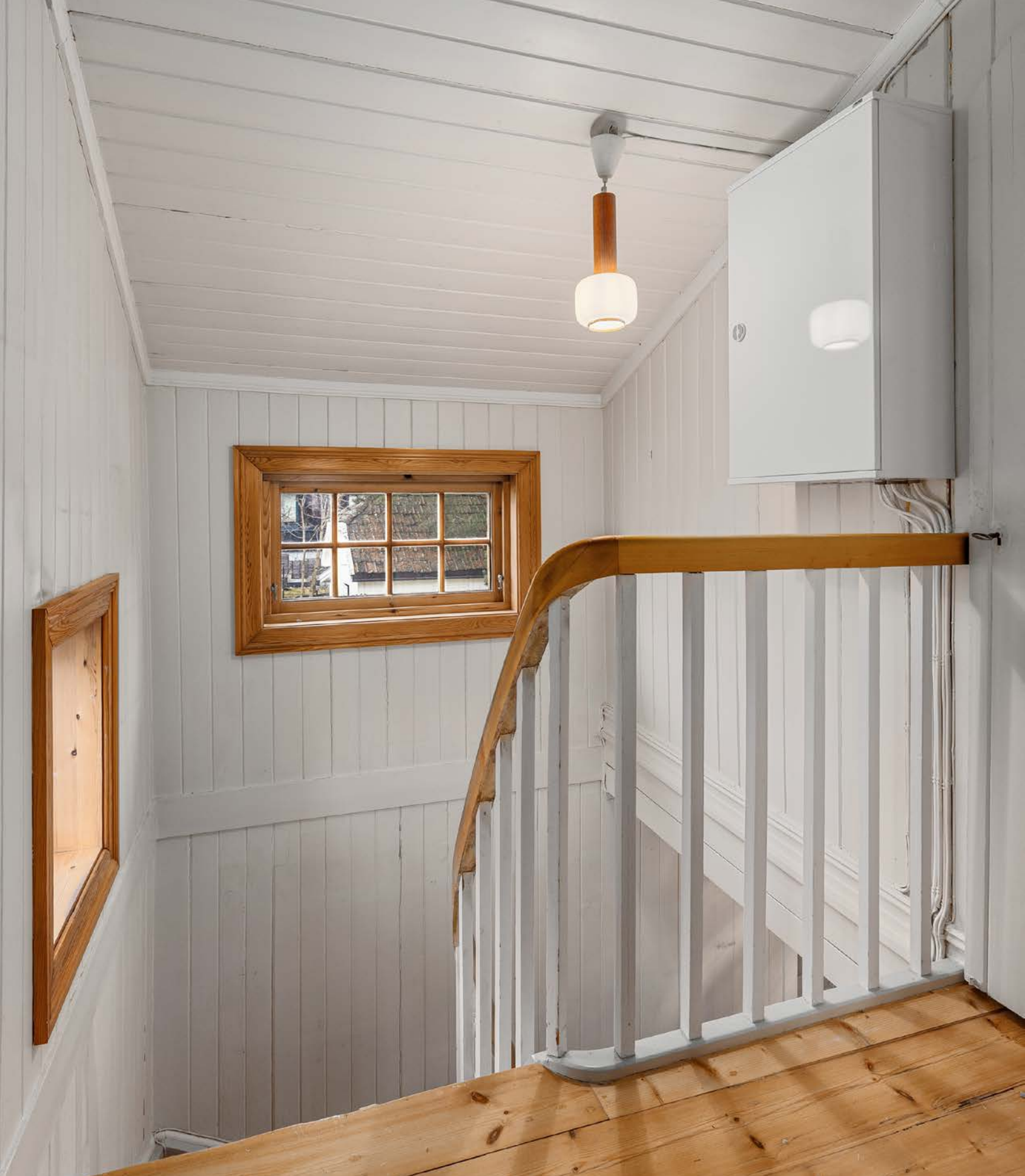
Trapp ned til 1 etasje med adkomst til bod.
