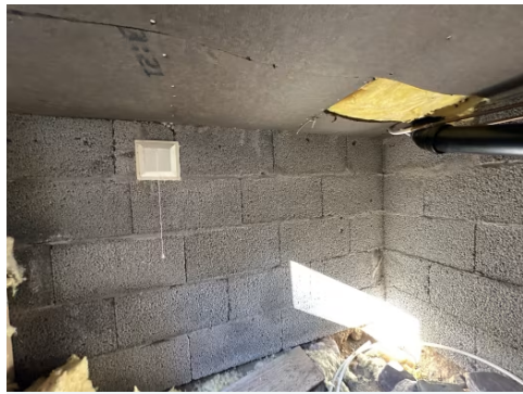
Viser åpninger i stubbloft.
