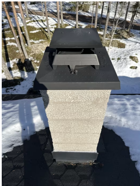
Viser pipe over tak.
