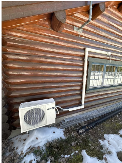
Viser utedel luft - luft varmepumpe.
