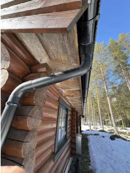
Det gjenstår arbeid ved takkonstruksjonen.
