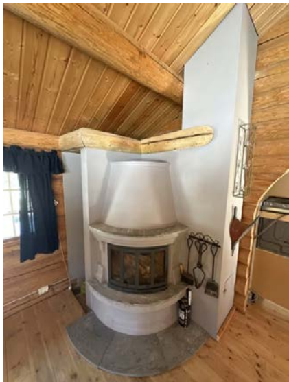
Viser ildsted montert i stue.
