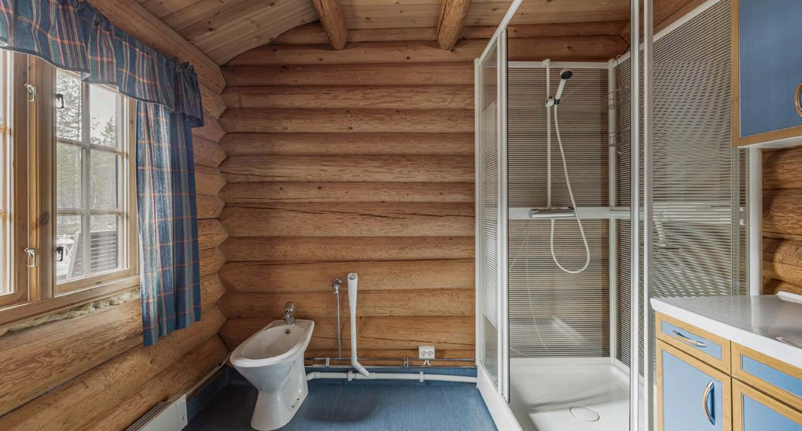
Baderommet har belegg på gulv, overflater av tømmer og trepanel i himlingen med nedfelte downlights. Rommet er utstyrt med innredning med servant, dusjkabinett, gulvstående toalett, bidé og opplegg for vaskemaskin.
