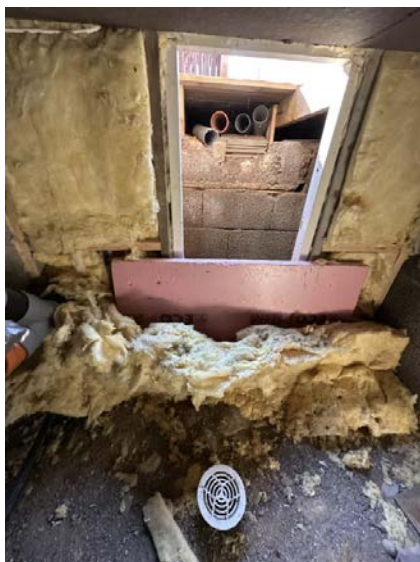
Åpen veggkonstruksjon, isolasjon fritt eksponert.
