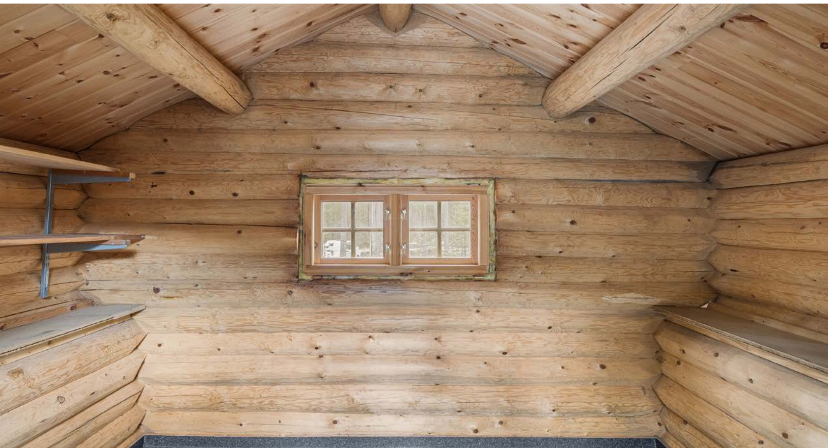
Anneks/uthus med belegg på gulv, tømmervegger og himling med trepanel. Det er innlagt lys og strøm.
