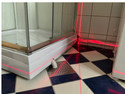
Fall på baderomsgulv er kontrollert med krysslaser.
