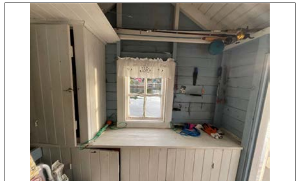
Vinduer med karm av tre og 1 og 2 lags glass.
