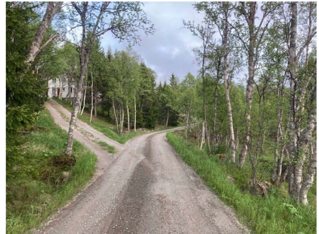
Figur 1: Bilde fra første del av Gamle Vintervoldveien etter avkjøringen fra Fv. 6536 (Foto. H. Vintervold)
