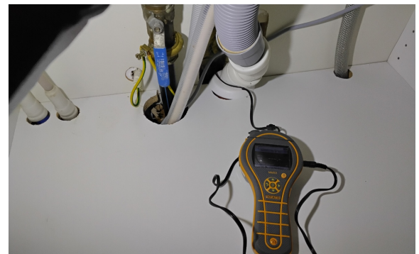
Fukt søk i vegg mot badet.
