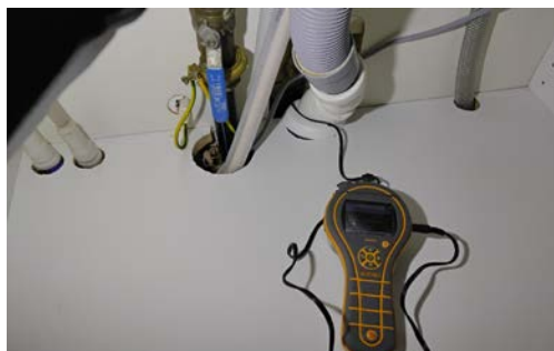
Fukt søk i vegg mot badet.
