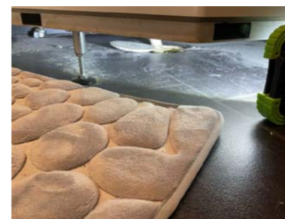
Sluk under dusjkabinett.
