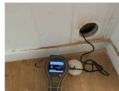
Fuktmåling i konstruksjonen mot bad.
