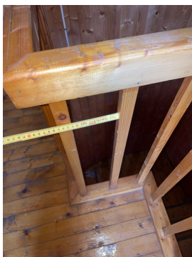
Åpninger over 10 cm. jmf. dagens regelverk.
