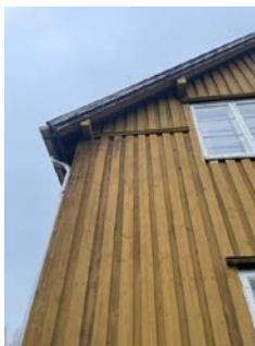
Skader i kledningsbord etter hakkespett
