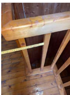
Åpninger over 10 cm. jmf. dagens regelverk.
