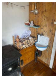
Enkel vannkran med utslagsvask på kjøkken.
