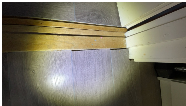
Manglende terskellist- tett lagt mot terskel (ufagmessig)
