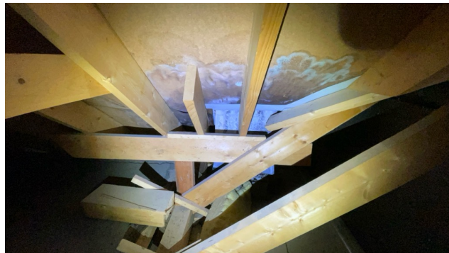
Utett pipegjennomføring
