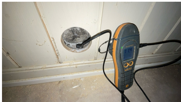
Hulltagning påvforingsvegg- fuktverdi 11 vekt% her (vurderes ikke skadlig)
