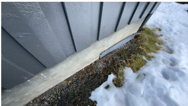
Fuktsperre stopper litt før entre
