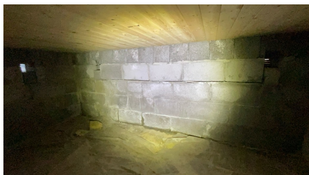
Større horisontal sprekk krypkjeller
