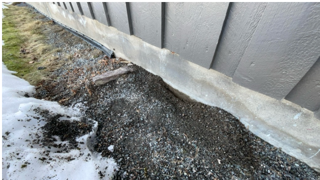
Fuktsperre stopper litt før entre
