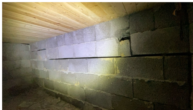
Større horisontal sprekk krypkjeller
