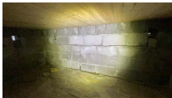
Større horisontal sprekk krypkjeller
