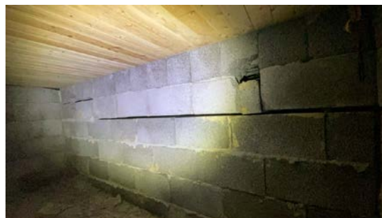
Større horisontal sprekk krypkjeller
