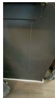
Manglende terskellist- tett lagt mot terskel (ufagmessig)
