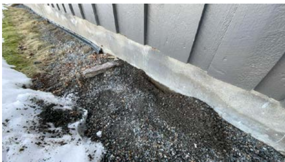
Fuktsperre stopper litt før entre
