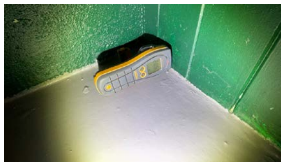
Fuktmåling panelvegg i rommet- 20 vekt%
