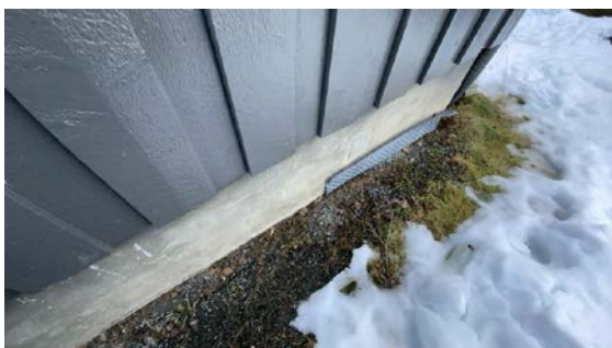
Fuktsperre stopper litt før entre
