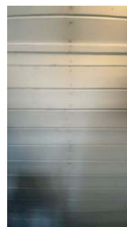
Litt svelling/hevelse laminatskjøt
