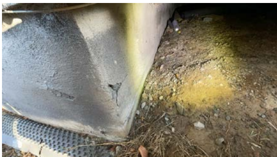
Ikke påvist fuktsperre under hele terrassen
