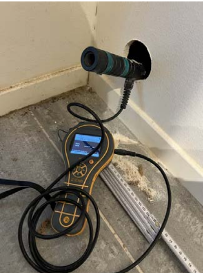
Det ble ikke registrert fukt ved hulltaking.
