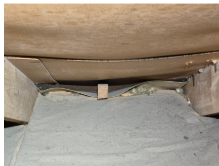
Lite luft i nedre del mot gesims.
