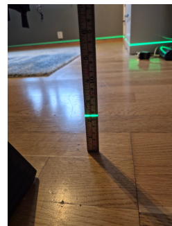
Målt høydeforskjell på soverom 1.
