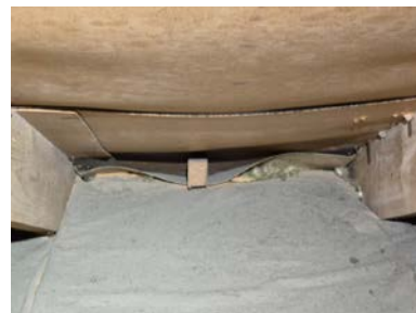
Lite luft i nedre del mot gesims.
