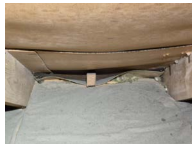
Lite luft i nedre del mot gesims.
