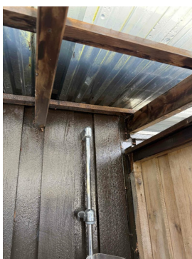
Bildet viser taket over sommerdusjen.
