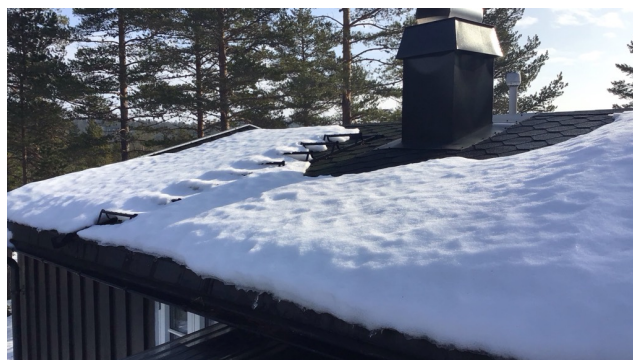
Bildet viser snødekte tak.
