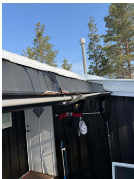
Bildet viser takrenne med lekkasje.
