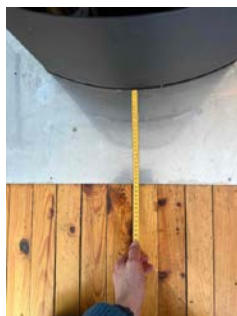
Bildet viser avstand fra ovn til brennbart materiale.
