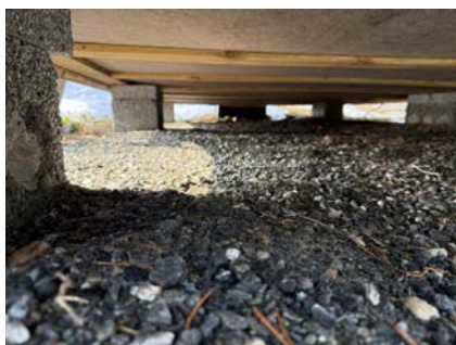
Bildet viser lettklinkerblokker under annekset.
