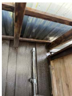
Bildet viser taket over sommerdusjen.
