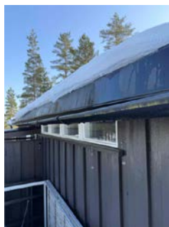
Bildet viser takrennen med deformasjon.
