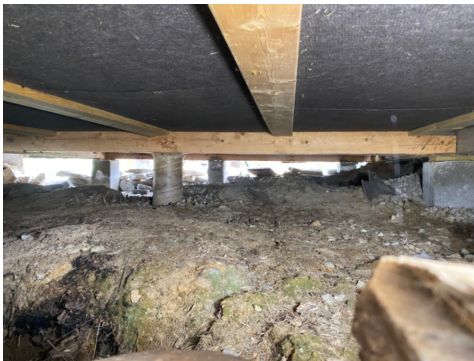
Stubbloft med asfaltplater
