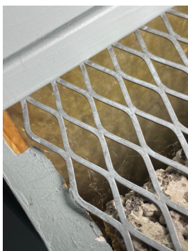
Synlig dampsperre/plast på innvendig vegg.
