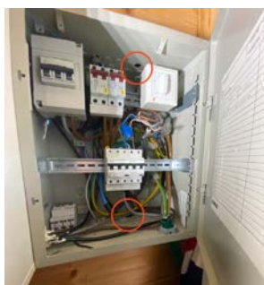
Sikringsskap med automatsikringer plassert på bod. Tegn på at åpninger i sikringsskap ikke er tette samt noe u- fagmessig utførelse.
