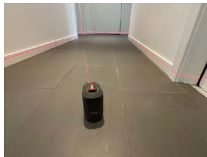
Nivellering entré, avvik ca. 10-20 mm
