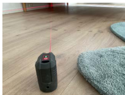
Nivellering soverom, ingen registrerte avvik
