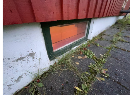
Vindu i underetasje
