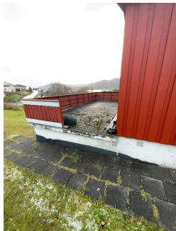
Trapp ved hovedinngang 1. etasje. Rekkverk må monteres.
