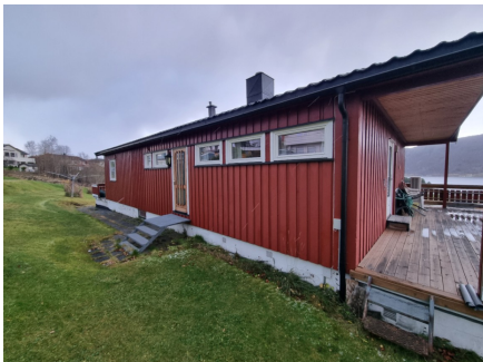
Vindu på bakvegg i stue, trapperom og bad
