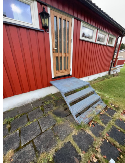
Trapp ved hovedinngang 1. etasje. Rekkverk må monteres.
