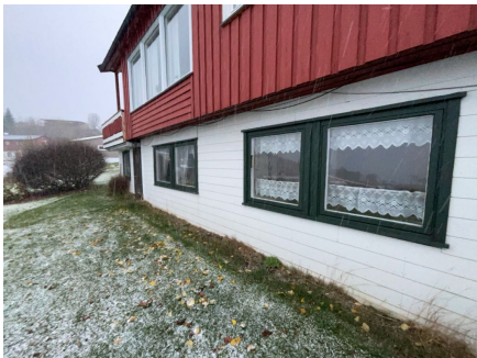
Vindu i underetasje
