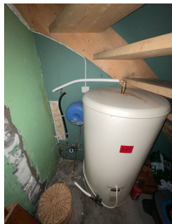
Hovedstoppekrane og vannmåler
