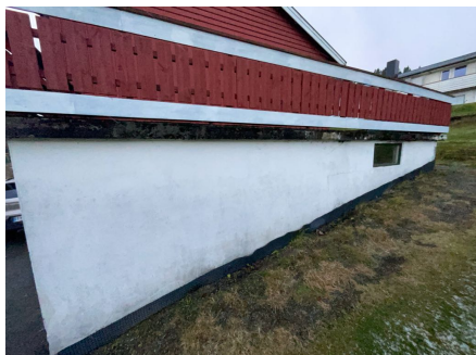
Oversikt garasjemur med grunnmursplast
