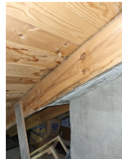
Eldre fuktmerker ved pipe. Ingen fukt på befaringsdagen
