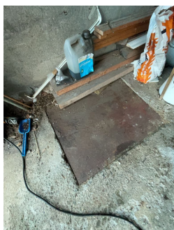
Luke i garasje for tilkomst til drenering, ikke åpnet og kontrollert
