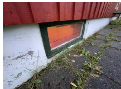
Vindu i underetasje
