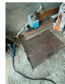
Luke i garasje for tilkomst til drenering, ikke åpnet og kontrollert
