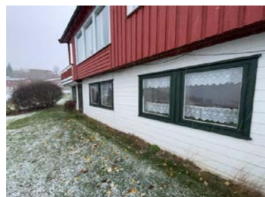
Vindu i underetasje
