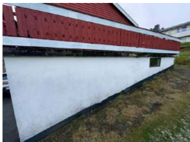
Oversikt garasjemur med grunnmursplast
