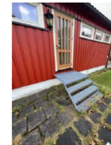
Trapp ved hovedinngang 1. etasje. Rekkverk må monteres.
