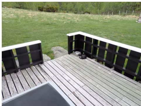
Oversiktsbilde. Man ser tydelig værslitasje i dekket.
