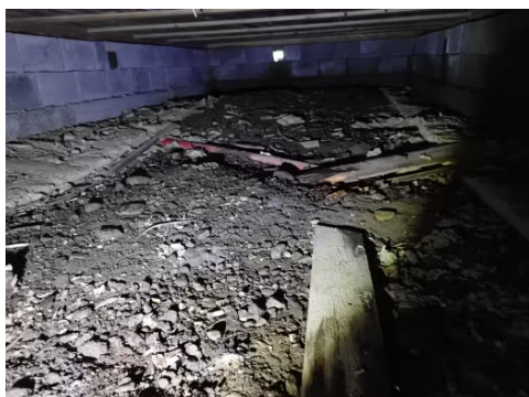
Oversiktsbilde i tilgjengelig krypkjeller.
