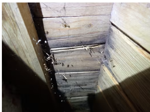
Skadet takpanel ved pipe.
