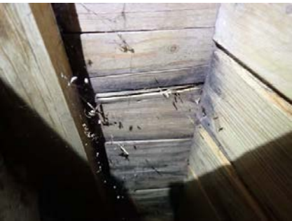
Skadet takpanel ved pipe.
