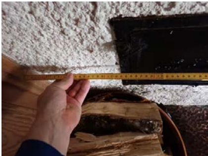
Avstand til sotluke.
