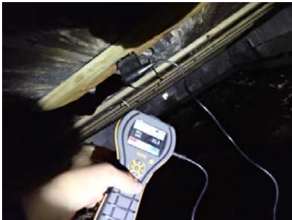
Fuktmåling i treverk i kryprom.
