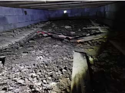
Oversiktsbilde i tilgjengelig krypkjeller.
