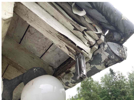
Råte i takspærre over entre.
