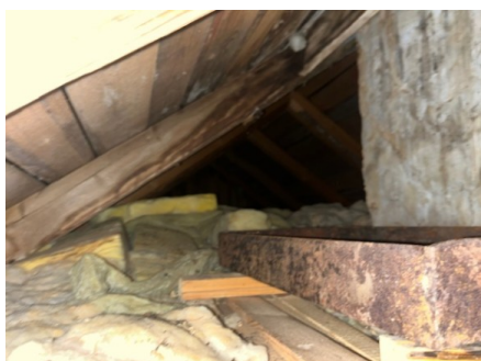
Råte i takspærre over entre.
