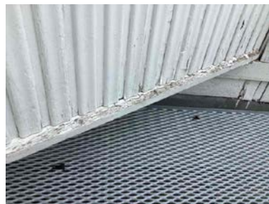
Slitasje på entredør.
