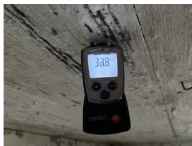
Fuktinnhold i treverk på over 30 vektprosent (fibermetning).
