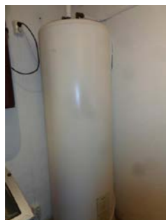
Varmtvannsbereider i kjellerrom.
