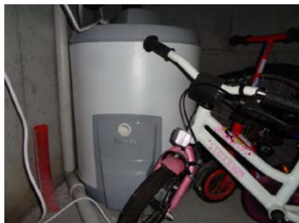
Varmtvannsbereider i kjellerrom.
