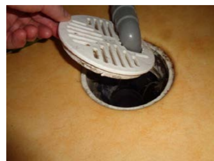
Plastsluk med klemring.
