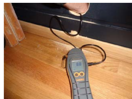
Ingen unormale fuktverdier registrert.
