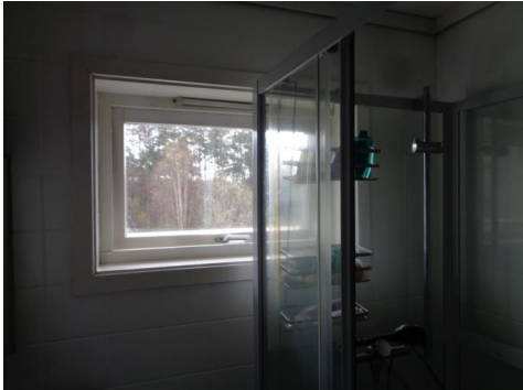
Vindu i dusjsone.
