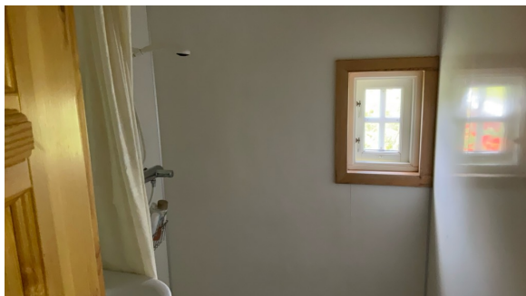
Det er vindu i våtsonen.
