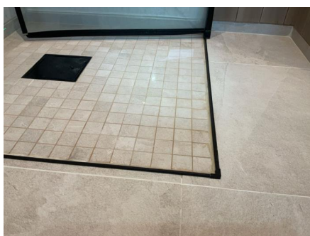
Vannspeil blir stående uten å renne til sluk.
