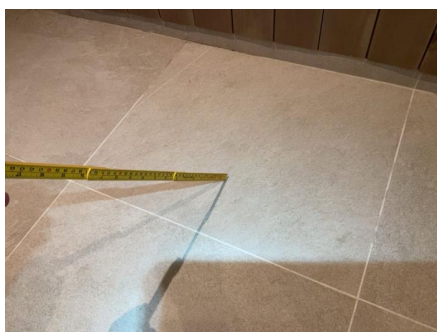
Vannspeil blir stående uten å renne til sluk.
