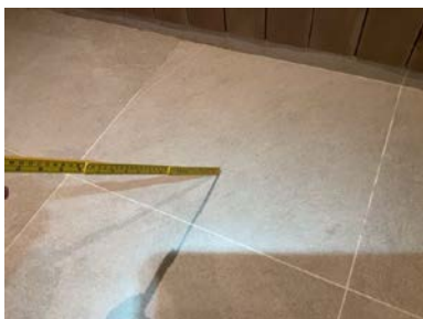
Vannspeil blir stående uten å renne til sluk.
