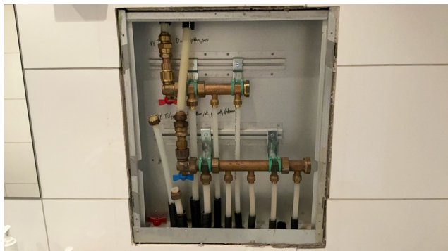
Besiktigelse av røropplegg.
