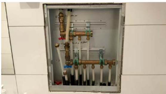
Besiktigelse av røropplegg.
