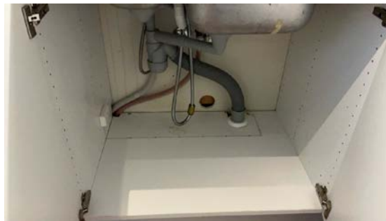
Besiktigelse av røropplegg.
