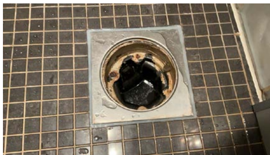
Kontroll av sluk.
