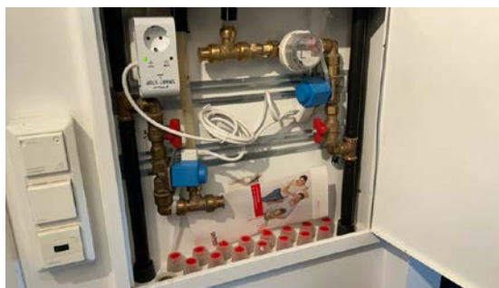
Besiktigelse av røropplegg.
