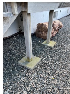
Tresøyler er plassert på betongheller.
