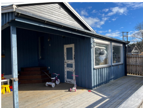
Pulttak konstruksjon over vinterhage og terrasse.
