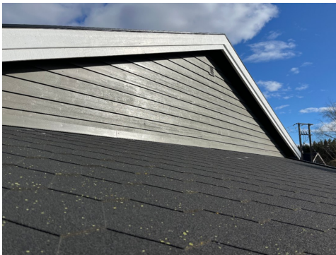
Nyere tak-shingel på tak over hagestue.
