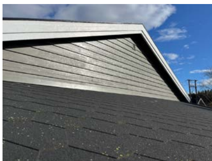
Nyere tak-shingel på tak over hagestue.
