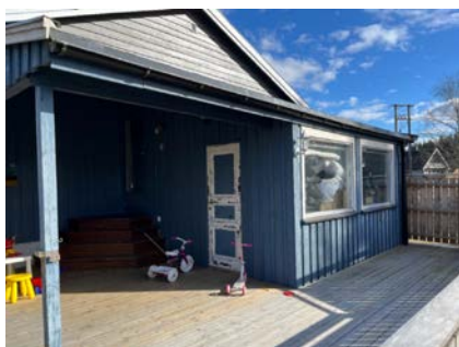
Pulttak konstruksjon over vinterhage og terrasse.
