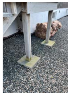
Tresøyler er plassert på betongheller.
