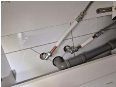
Utette rørgjennomføringer.
