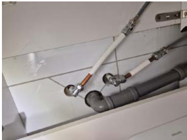
Utette rørgjennomføringer.
