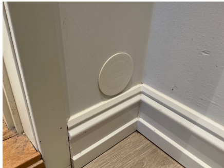
Hull ble plombert med plastlokk.
