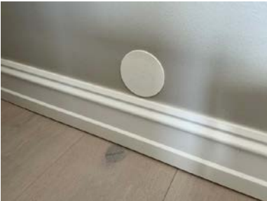
Hull ble plombert med plastlokk.
