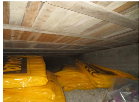
Glava vintermatte i tillegg til Glasoporen. Mattene anbefales lagt utover hele arealet/kryprommet.
