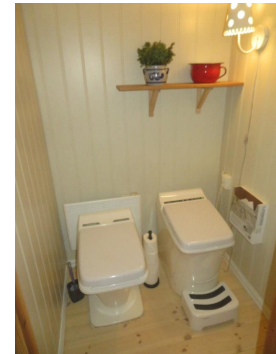
Toalettrom med pissoardo samt forbrenningstolett.
