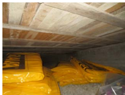
Glava vintermatte i tillegg til Glasoporen. Mattene anbefales lagt utover hele arealet/kryprommet.
