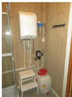
Vannsisterne samt åpent røropplegg med trykkpumpe. Vegghengt varmtvannsbereder.
