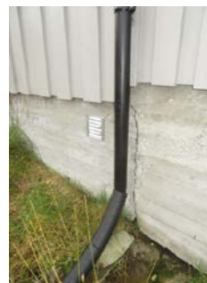
Eksempel på nedløpsløsning - nedløpsrør ført videre i plast drenerør lagt til terreng.
