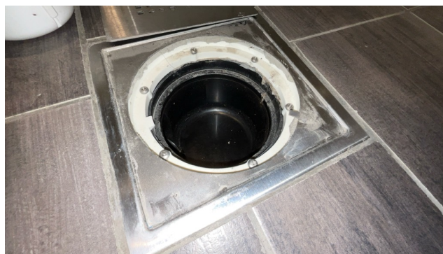
Kontroll av sluk.
