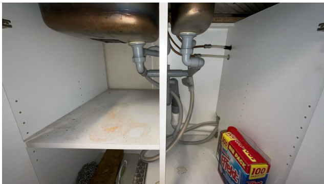
Besiktigelse av røropplegg.
