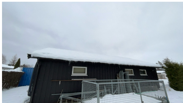
Besiktigelse av taktekke.
