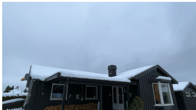
Besiktigelse av taktekke.
