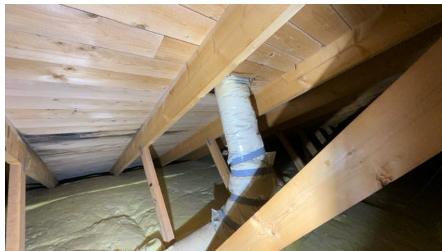
Kontroll rundt rørgjennomføringer.
