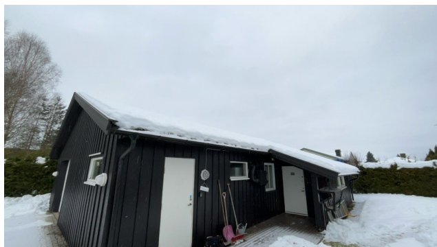
Besiktigelse av taktekke.
