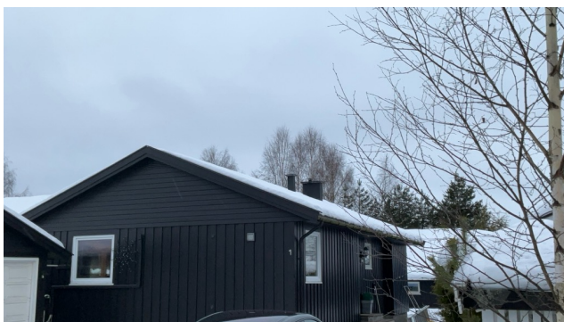
Besiktigelse av taktekke.
