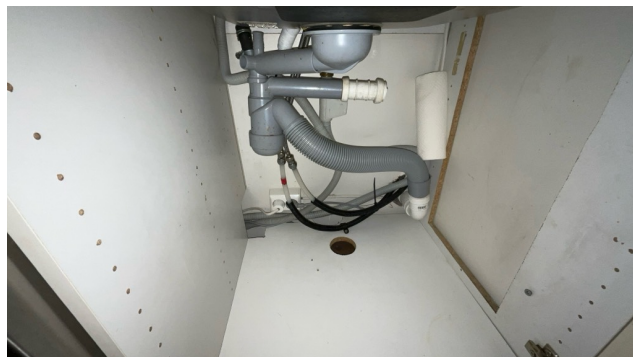
Besiktigelse av røropplegg.
