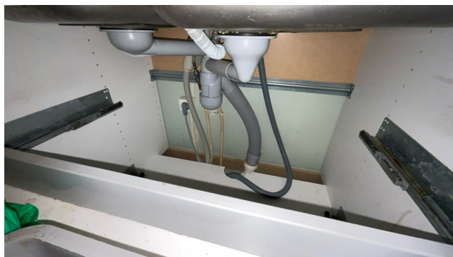
Besiktigelse av røropplegg.
