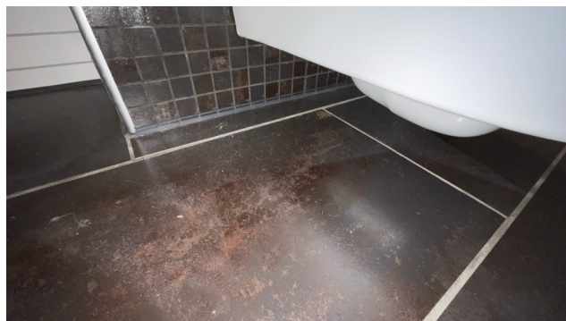
Det er ikke påvist tilfredsstillende løsning for å synliggjøre lekkasje fra innebygget sistene.
