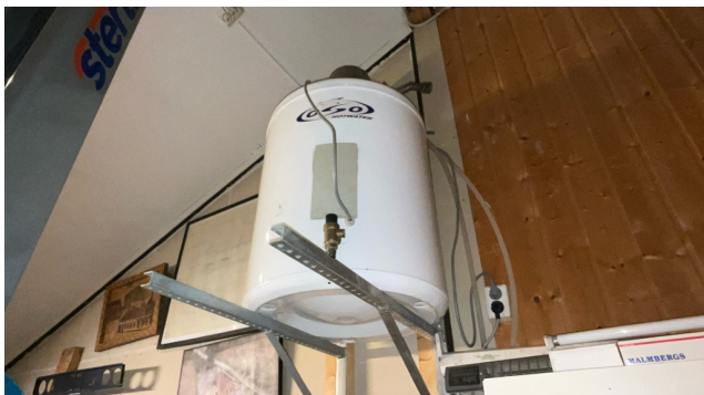
Besiktigelse av bereder.
