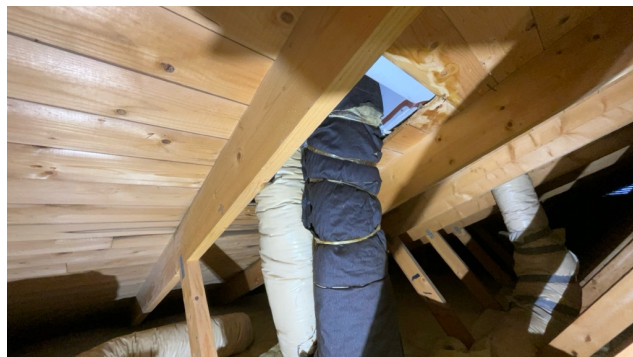
Kontroll rundt rørgjennomføringer.
