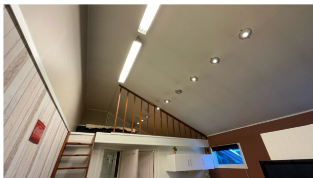
Ingen synlige lekkasjer på innvendige takflater på befaringsdagen.
