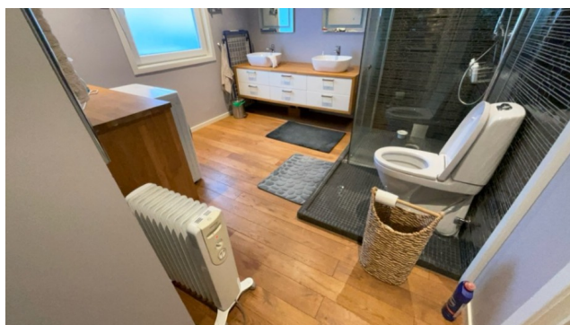
Dusjnisse med sluk dog utenforliggende gulv av parkett.
