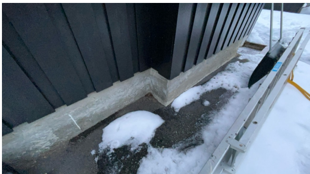
Kontroll av drenering/fuktsikring.
