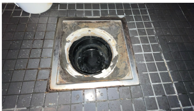
Kontroll av sluk.
