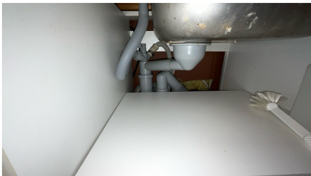
Besiktigelse av røropplegg.
