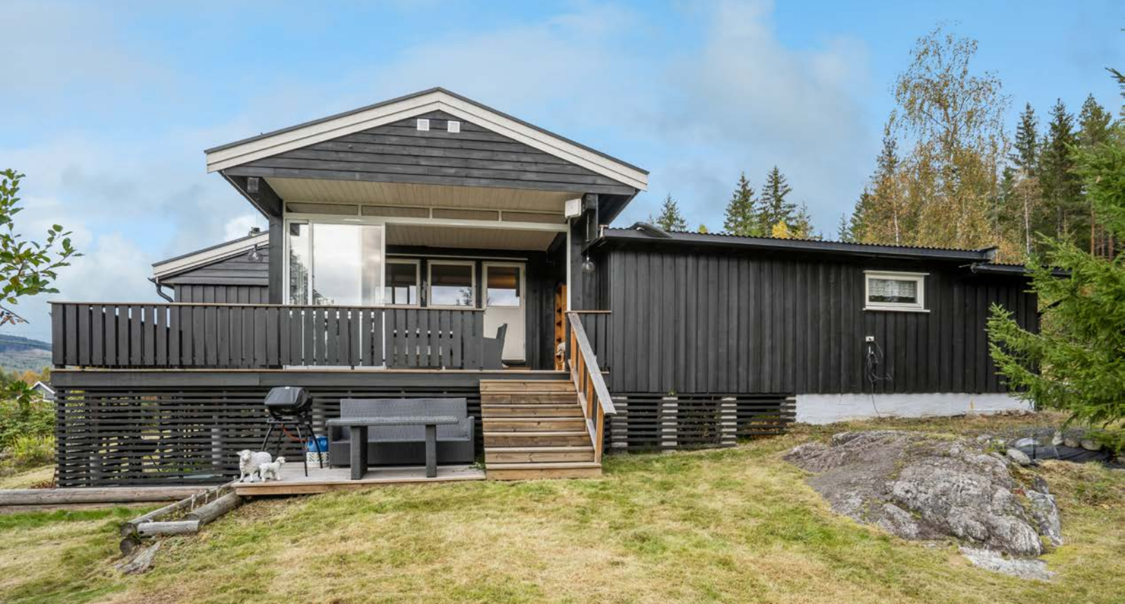
I tillegg er det en liten platting på terreng.
