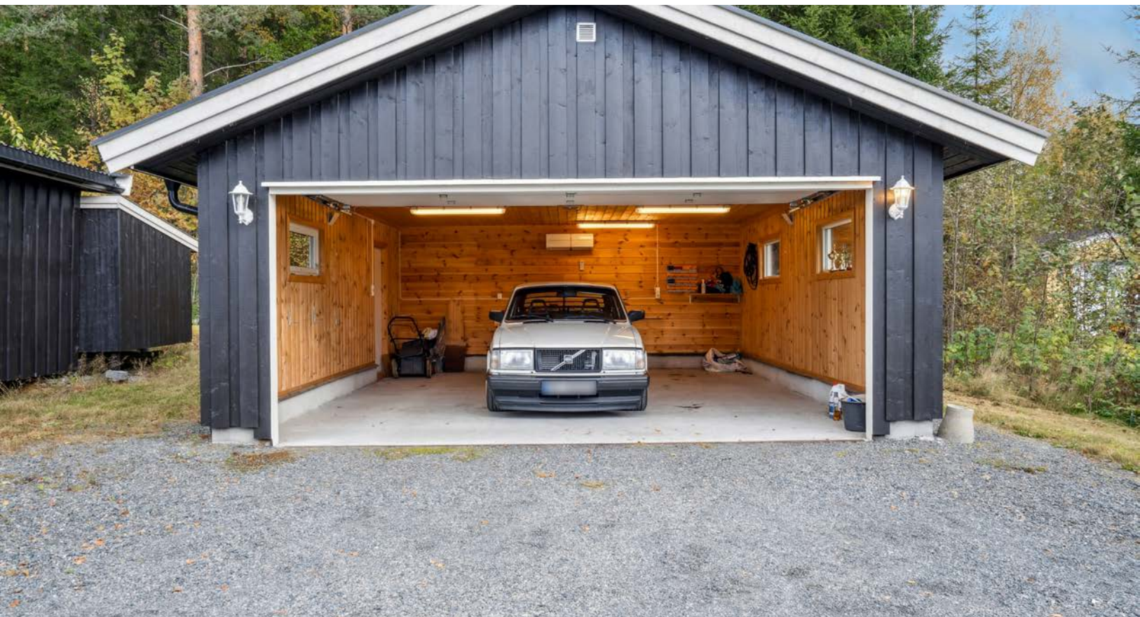
Isolert dobbelgarasje bygget i 2014.
