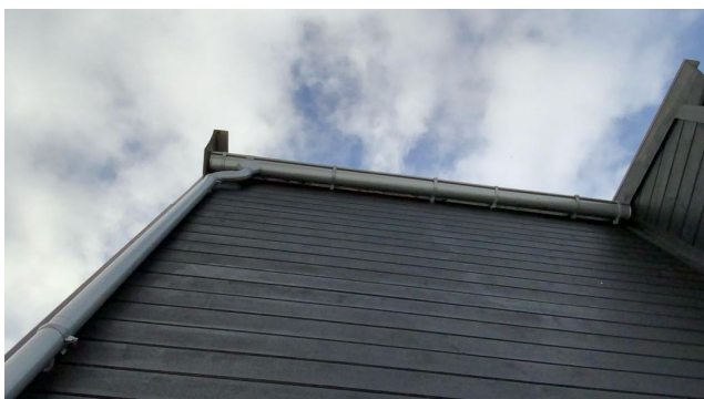
Synlige luftespalter i gesimskasse bak takrenne.
