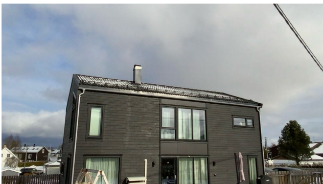
Besiktigelse av taktekke.
