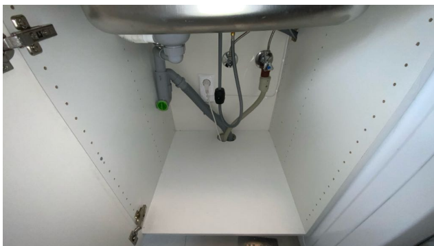
Besiktigelse av røropplegg.
