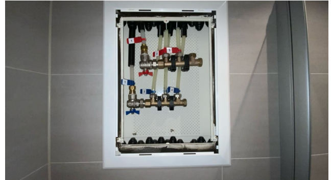
Besiktigelse av røropplegg.
