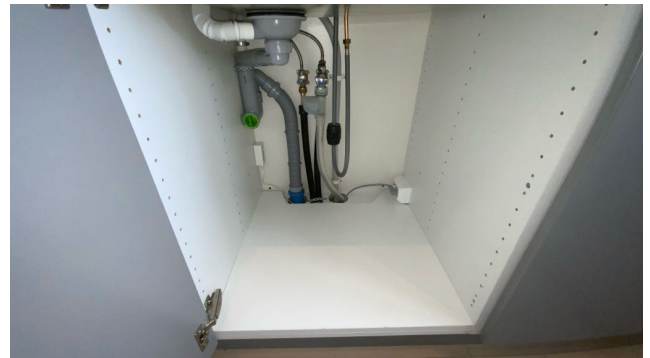
Besiktigelse av røropplegg.
