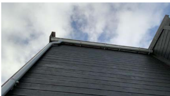
Synlige luftespalter i gesimskasse bak takrenne.
