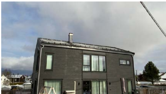
Besiktigelse av taktekke.
