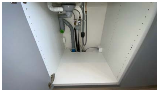
Besiktigelse av røropplegg.
