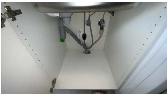
Besiktigelse av røropplegg.
