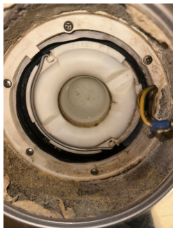
Plastsluk med klemring for membran
